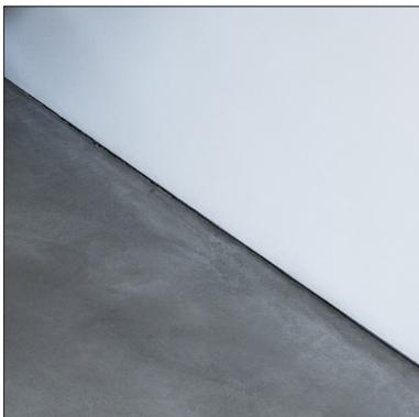
Rivestiti con isolamento e con cartongesso liscio a gesso, 2 mani di pittura minerale
